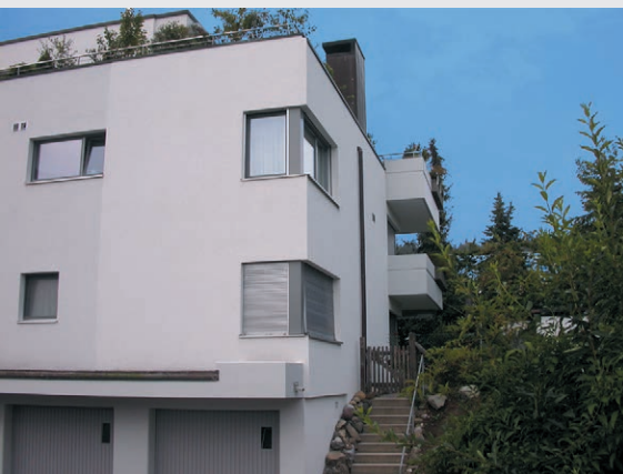
Ergebnis nach der Sanierung
